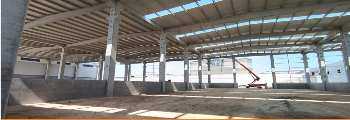
Yatırım Projesi İsmi: D Blok Depolama Tesis
